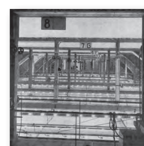
Saalzwischendecke (Laufbrücken, Licht)
